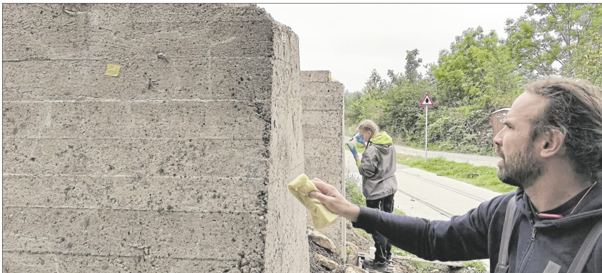
Sicherungsarbeiten an den Kranfundamenten des Rüstungsprojekts „Stoffel“ des Dritten Reichs in Vaihingen. Restauratoren schließen die Risse und Löcher im Beton.
