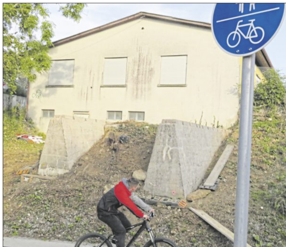
Unterhalb des Vaihinger Kleintierzüchterheims befinden sich die Fundamente für eine Krananlage aus der NS-Zeit.
